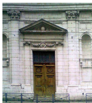
Entrée du lycée
